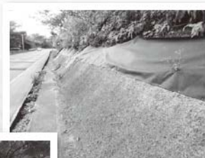
道路脇の視認性改善のための張りコンクリートと防草シート
